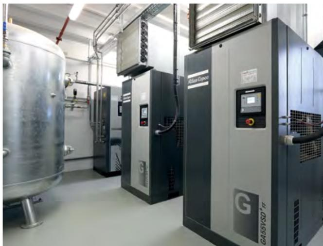
Die neue Druckluft- und Stickstoffstation bei Vitakraft umfasst fünf drehzahlgeregelte GA-VSD-Kompressoren (zwei im Bild) sowie einen Stickstoffgenerator des Typs NGP 100<sup>+</sup> (hinten im Bild).
