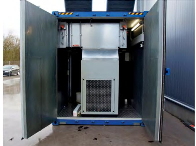
Den knappen Raum im Container teilen sich zwei ölfrei verdichtende Kompressoren des Typs AQ 22 VSD FF mit einem 1000-Liter-Speicher, zwei Vakuumpumpen, einem Schaltschrank sowie der Be- und Entlüftungsanlage.
