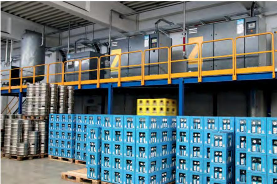
Die Druckluftstation steht in der Lagerhalle. Mit der warmen Abluft wird die Halle erwärmt, so dass die Etiketten auf den frisch abgefüllten Flaschen schnell trocknen. Früher musste hier geheizt werden.
