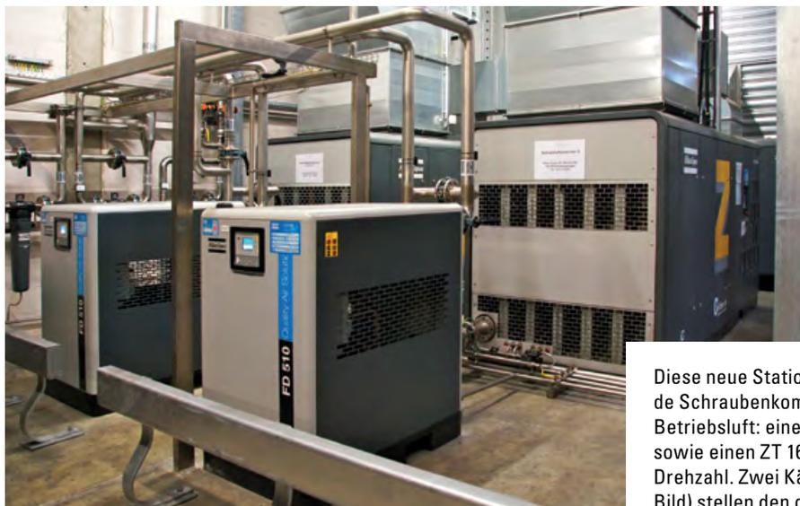
Diese neue Station beherbergt drei ölfrei verdichtende Schraubenkompressoren für die Produktion von Betriebsluft: einen ZT 160 VSD mit Drehzahlregelung sowie einen ZT 160 und einen ZT 145 FF mit fester Drehzahl. Zwei Kältetrockner von Atlas Copco (vorn im Bild) stellen den gewünschten Drucktaupunkt sicher.
