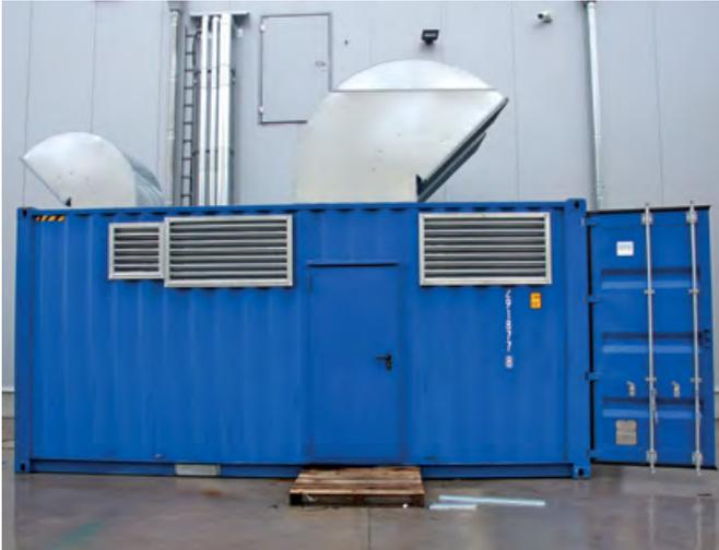
Schnell und einfach installiert: Am neuen Standort in Wiesentheid musste der schlüsselfertige Container lediglich abgeladen, an die Strom- und Wasserversorgung angeschlossen und mit dem Druckluftnetz verbunden werden.
