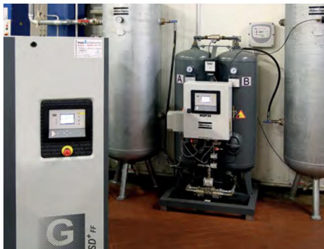
Diese „Prototypen“-Station mit einem kleinen GA-Kompressor und einem dazu passenden Stickstoffgenerator des Typs NGP 30 war die erste Anlage zur eigenen Stickstoffherzeugung. Sie steht in unmittelbarer Nähe der Fleischverarbeitung bei Vitakraft.
