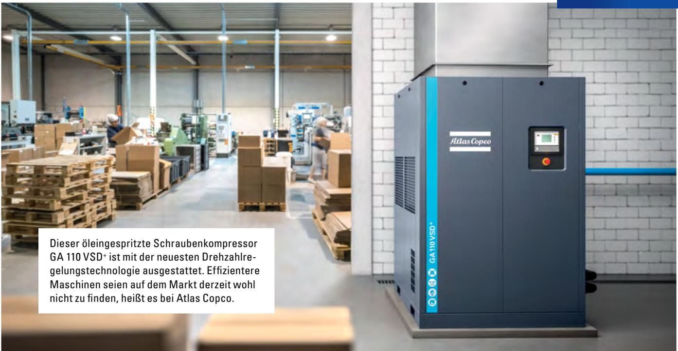
Dieser öleingespritzte Schraubenkompressor GA 110 VSD<sup>+</sup> ist mit der neuesten Drehzahlregelungstechnologie ausgestattet. Effizientere Maschinen seien auf dem Markt derzeit wohl nicht zu finden, heißt es bei Atlas Copco.
