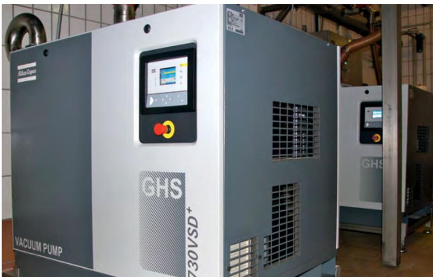
Seit März 2017 arbeiten in der gemeinsamen Vakuumstation der Abteilungen „Baked Potatoes“ und „Speisekartoffeln“ eine drehzahlgeregelte Schraubenvakuumpumpe GHS 730 VSD<sup>+</sup> sowie eine GHS 900 VSD<sup>+</sup>. Die Maschinen versorgen die Verpackungsanlagen mit einem bedarfsgerechten Vakuum bei einem konstanten Druck von 50 mbar absolut.
