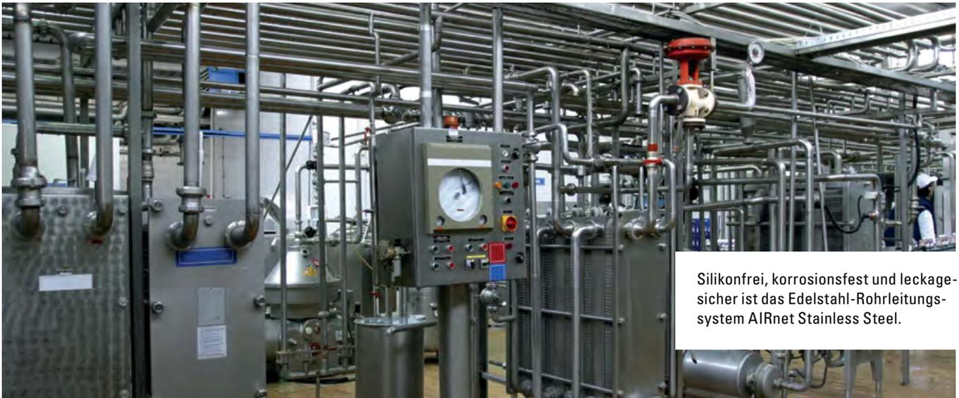
Silikonfrei, korrosionsfest und leckagesicher ist das Edelstahl-Rohrleitungssystem AIRnet Stainless Steel.
