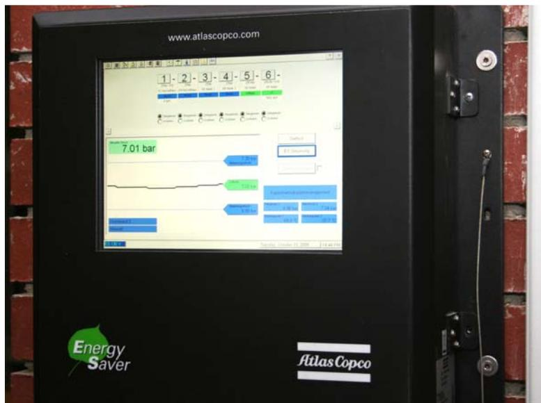
*Das Energiesparsystem ES 2000 von Atlas Copco regelt bei Bedarf alle Kompressoren bei Wernsing zusammen. Dabei werden insbesondere die beiden drehzahlgeregelten VSD-Verdichter so gesteuert, dass sie jeweils möglichst nahe an ihrem jeweiligen optimalen Betriebspunkt arbeiten. (Bild: Atlas Copco Kompressoren und Drucklufttechnik)*
