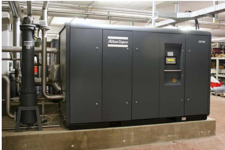
*Zwei wassergekühlte, ölfrei verdichtende Schraubenkompressoren der ZR-Baureihe liefern Wernsing saubere Druckluft für Produktion, Förder- und Verpackungstechnik. Um den schwankenden Bedarf möglichst verlustfrei abzudecken, ist der größere – ein ZR 250 VSD – mit einer Drehzahlregelung ausgestattet (VSD – Variable Speed Drive).*
