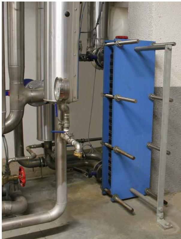
*Im Wesentlichen genügt ein separater Wärmetauscher (blau), um die Abwärme der Kompressoren zurückzugewinnen. Der Lebensmittelhersteller Wernsing kann dadurch zusätzliche 350 kW Heizleistung für die Vorerwärmung von Weichwasser zur Dampferzeugung nutzen. (Bild: Atlas Copco Kompressoren und Drucklufttechnik)*
